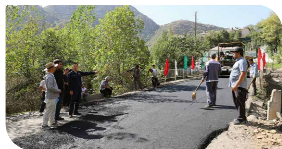
▲ 中色国矿帕鲁特公司募集资金 70 余万人民币，委托塔吉克斯坦当地专业施工队伍，对总长约 5 公里的因灾严重受损的道路重新修缮铺装沥青路面
