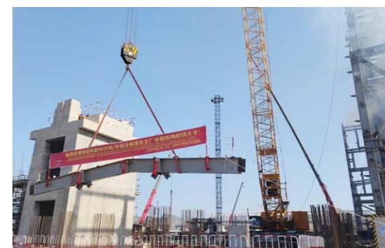
▲ 印尼阿曼铜冶炼项目熔炼主厂房钢结构顺利封顶
